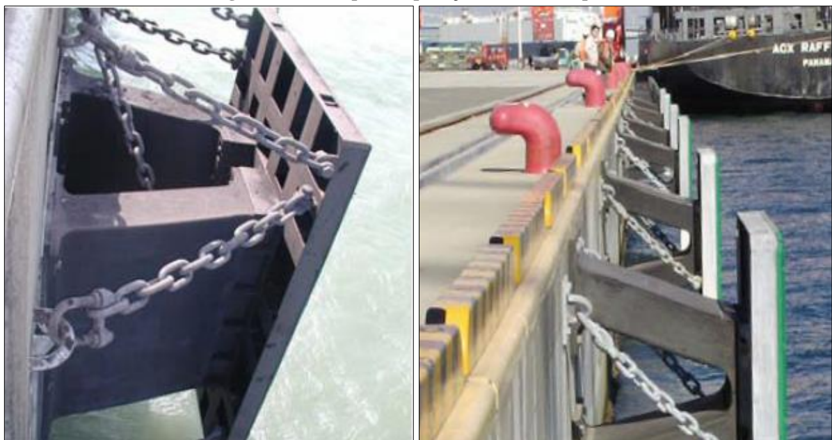
Figura 41 – Exemplo de aplicação de defesa tipo PI
