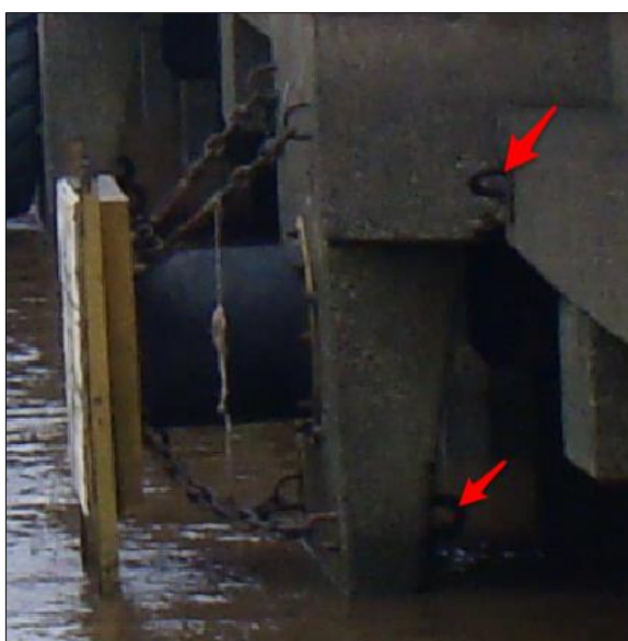
Figura 48 – Detalhe de uma defesa cilíndrica axial afixada em uma pestana
