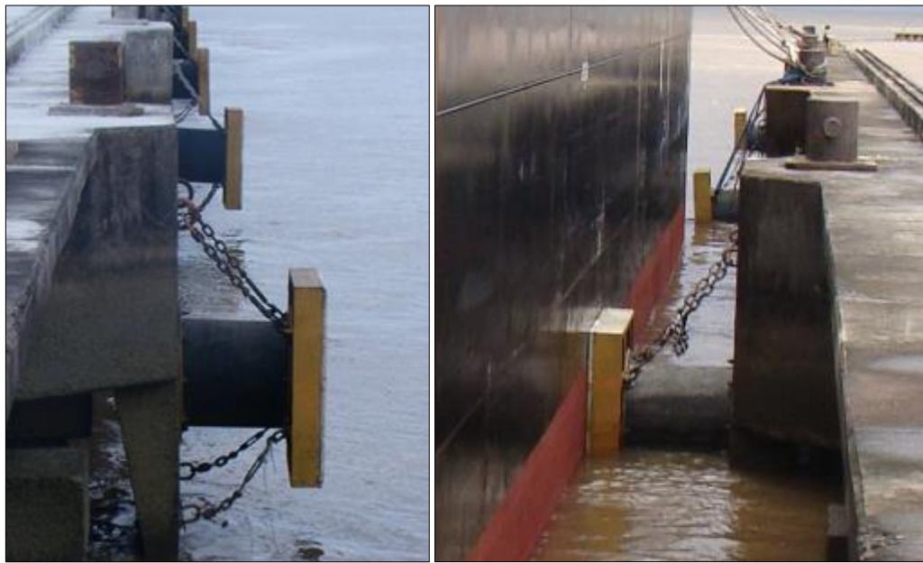
Figura 40 – Exemplo de aplicação de defensas cilíndricas axiais
