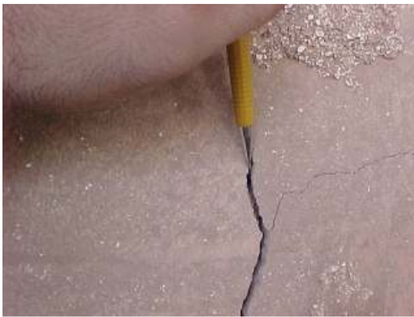
FIGURA 3.12 – Detalhe da trinca na parede de concreto isolante
