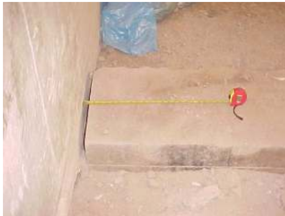
FIGURA 5.2 – Junta de dilatação na viga
