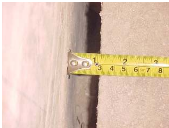
FIGURA 5.3 – Detalhe da junta de dilatação
