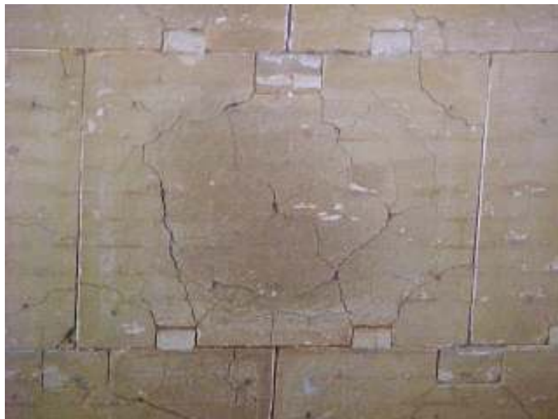
FIGURA 3.10 – Camada referente aos blocos de concreto isolante
