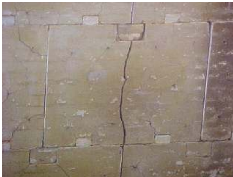
FIGURA 3.11 – Camada referente aos blocos de concreto isolante
