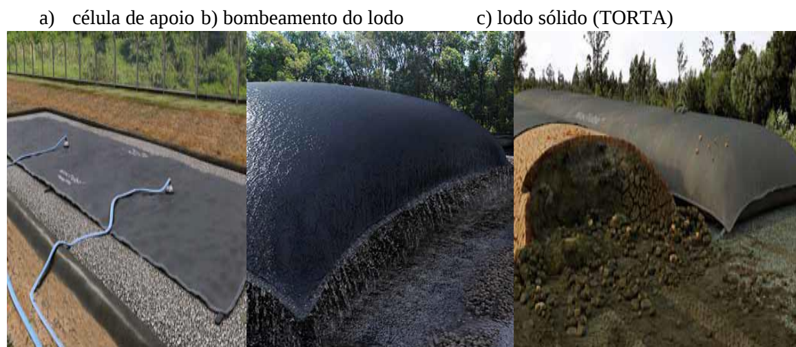
Figura 1 - Etapas da desidratação do lodo em geomembrana. Figuras a, b e c.
