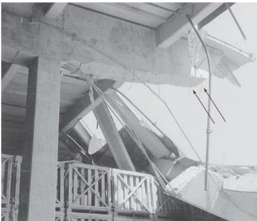
Figura 4.17 - Falha de cisalhamento: Depósito da Força Aérea dos EUA (MACGREGOR, 2009)
