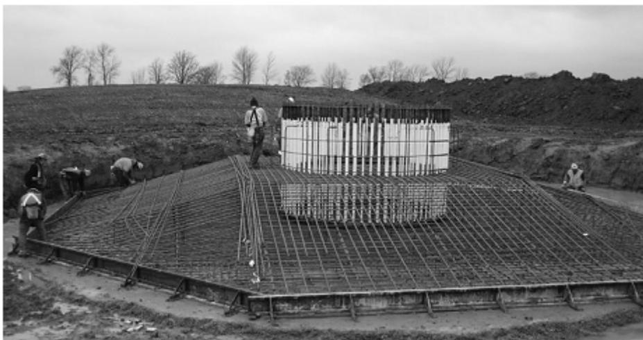
Figura 4.2– Fundação de uma turbina eólica (MACGREGOR, 2009)
